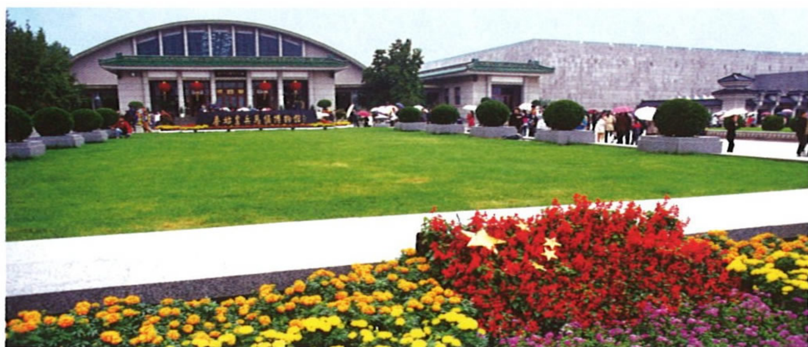
兵馬俑一号坑の大門
